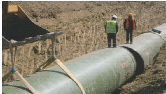
Раструбное соединение с двойным уплотнительным кольцом, для трубных соединений с номинальным давлением более 6 атм.
