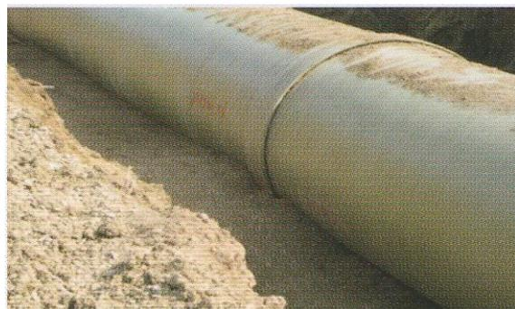
В особых случаях (на стыках трубопроводов, при проведении труб через гильзы на пересечениях с автомагистралями, в замкнутых системах циркуляции) также применяется жесткое соединение (ламинация).
